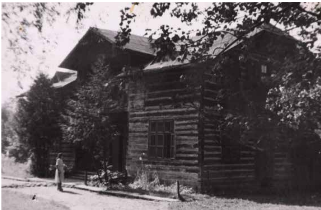
51 „Korytnianka” w czasie budowy początek lat 30.
